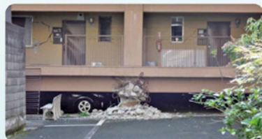
写真1:2016年熊本地震の被害の様子、1階の柱が建物の重量を支えられなくなっています。
